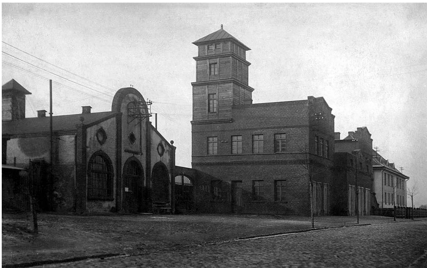
Il. 8. Puck. Budynek straży pożarnej i elektrowni, 1930 (fotografia, Muzeum Ziemi Puckiej, sygn. MZP-H-163)
