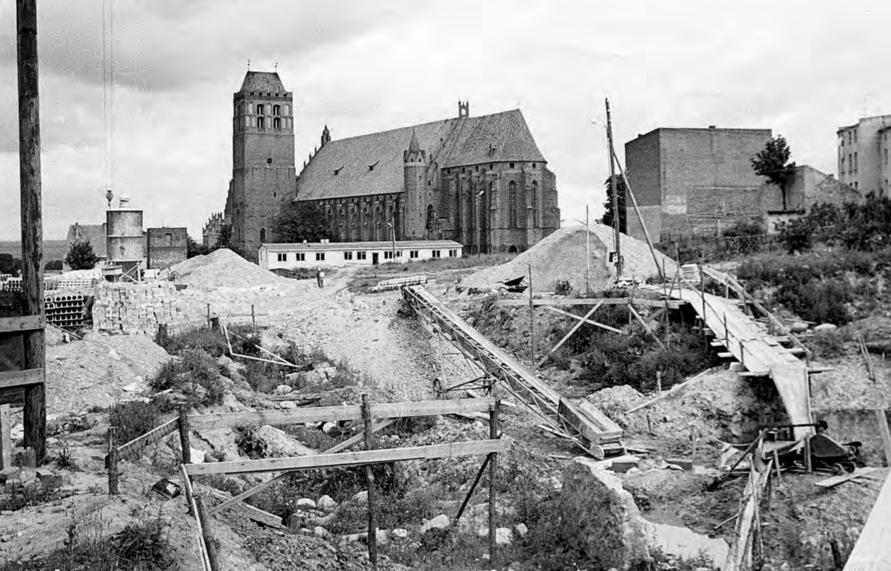
Il. 32. Kwidzyn. Budowa osiedla mieszkaniowego na terenie zburzonego starego miasta, 1967 rok (fot., ze zbiorów prywatnych Justyny Liguz) Il. 32. Kwidzyn. Construction of a housing estate on the site of the demolished Old Town, 1967 (photograph from the private collection of Justyna Liguz)
