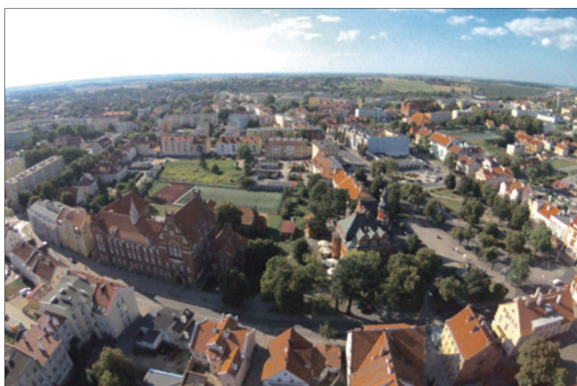
D. Kętrzyn – widok od strony wschodniej na teren dawnego Chłopskiego Przedmieścia. Na pierwszym planie budynek dawnego Gimnazjum Księcia Albrechta i ratusz. Z prawej strony plac J. Piłsudskiego (dawny plac Wilhelma) | Kętrzyn - view from the east of former Peasant Suburb. In the foreground, the building of the former Prince Albrecht Middle School and the town hall. On the right, Józef Piłsudski Square (former Wilhelm Square).
