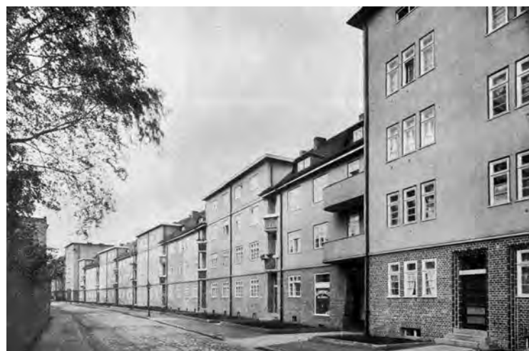
43. Modernistyczna zabudowa z końca lat 20. XX w. przy Fischersgasse (ob. ul. Rybacka), za: Walther Tscheschner, Aus der Geschichte der Stadt Brieg , Düsseldorf-Kaiserwerth 1930.
