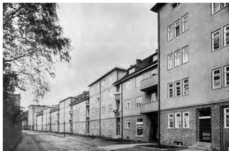
43. Modernist buildings from the late 1920s at Fischerstrasse (now ul. Rybacka), after: Walther Tscheschner, Aus der Geschichte der Stadt Brieg , Düsseldorf-Kaiserwerth 1930.
