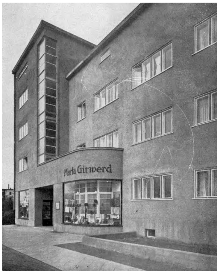
42. Modernistyczna zabudowa z lat 1928–1930 przy Logastrasse (ob. Władysława Łokietka), za: Walther Tscheschner, Aus der Geschichte der Stadt Brieg , Düsseldorf-Kaiserwerth 1930.
