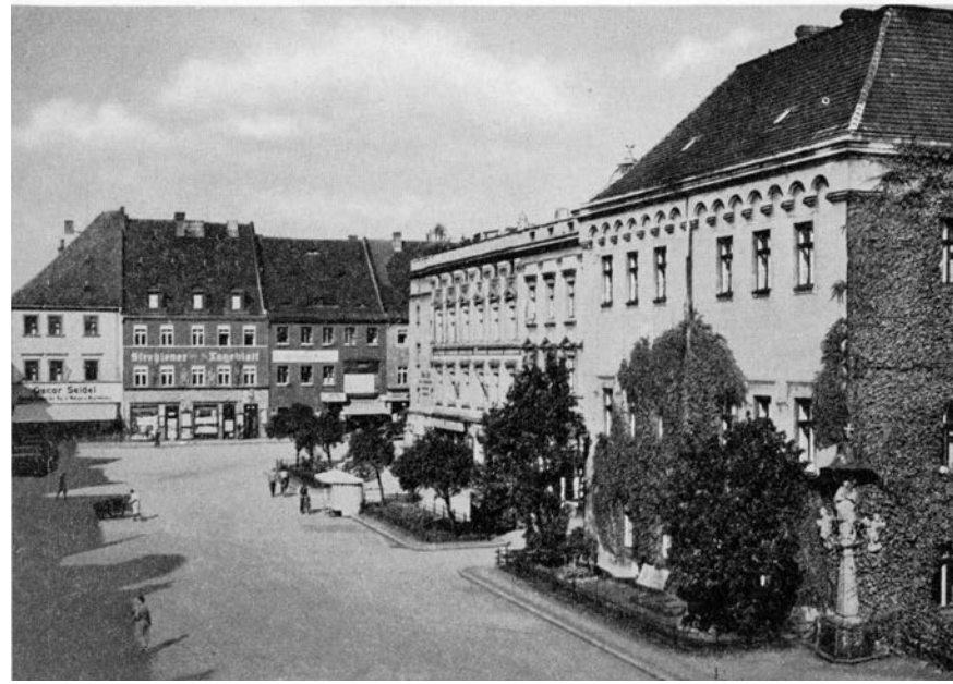
15. Strzelin. Widok bloku śródmiejowego od południowo-zachodu, przed 1935
