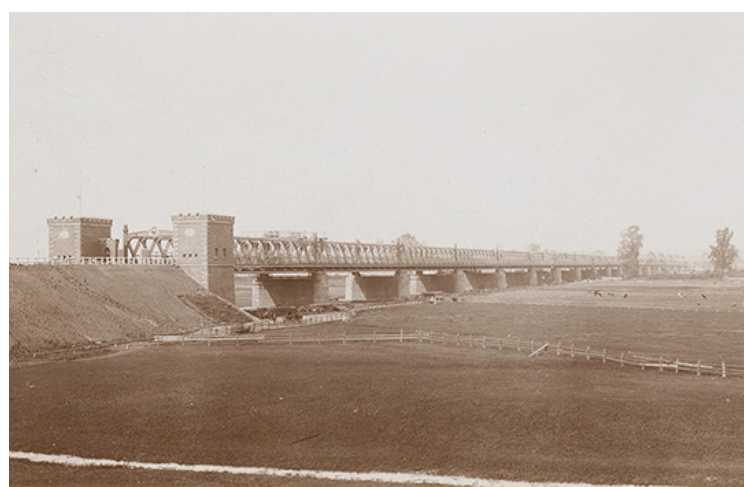
Il. 5. Fordon. Most przez Wisłę – widok ogólny od południowego wschodu, 1893 (fotografia ze zbiorów Architekturmuseum der Technischen Universität Berlin, nr inwentaryzacyjny BZ–F 16,002)
