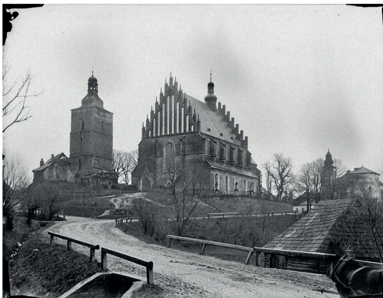
2.13. Biecz, widok od południowego zachodu, 1896 View of Biecz from the south-west, 1896
